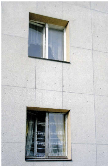
Ar sildpaneļiem izolēta fasādes virsma.
