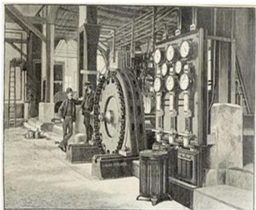
5. att. Laufenē uzstādītā trīsfāžu dinamomašīna.
