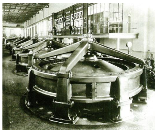
7.att. Pirmā trīsfāžu maiņstrāvas elektrostacija ar uzstādīto jaudu 12000kW.
