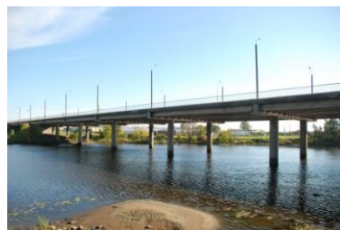
Fig. 2. Bridge over Bieķengrāvis
