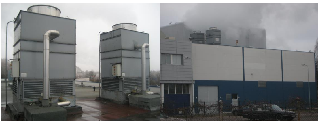
Иллюстрация №4. Градирни открытого типа теплоцентрали "Imanta"
