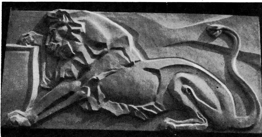
Рис. 4. Экран лоджии административного здания, изготовленный методом ударной технологии
