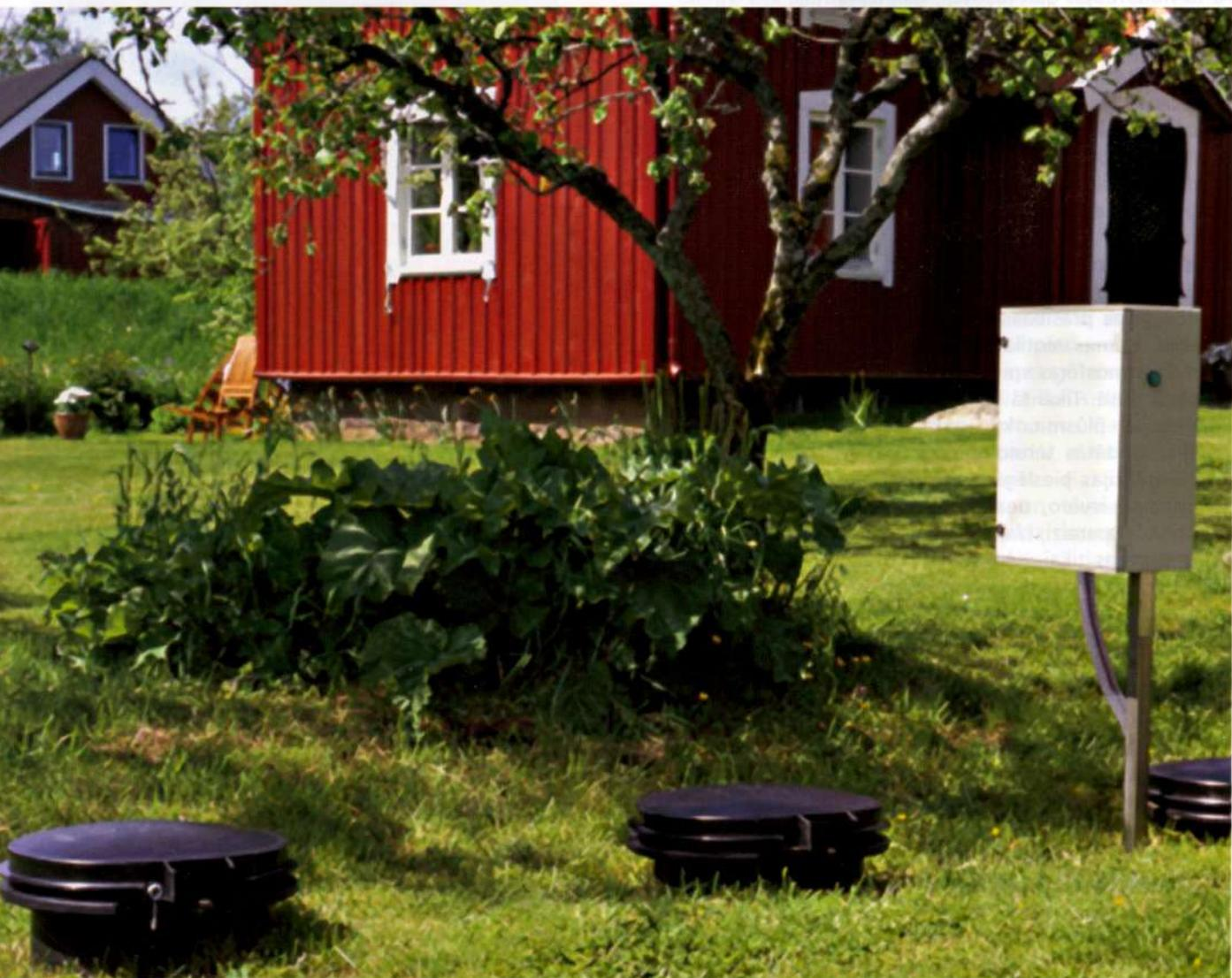
Ceļot jaunu mitekli, ja tuvumā neatrodas centralizētā kanalizācija, jāparedz notekūdeņu attīrīšanas sistēma. Šodien tirgū ir pieejamas dažādas jaudas un veidu sadzīves notekūdeņu attīrīšanas ietaises.
