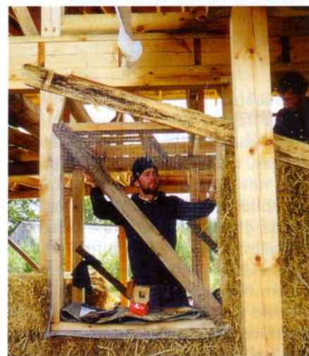
«Rožkalnu» rietumu, austrumu un ziemeļu sienas ir celtas no salmu ķīpām, kas sagatavotas gadu iepriekš.
