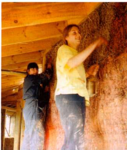
«Rožkalnu» rietumu, austrumu un ziemeļu sienas ir celtas no salmu ķīpām, kas sagatavotas gadu iepriekš.
