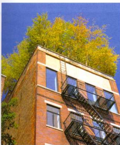
Zaļie jumti ir samērā vienkārši kopjami un uzraugāmi, ja tie jau sākotnēji tiek profesionāli projektēti un ierīkoti.
