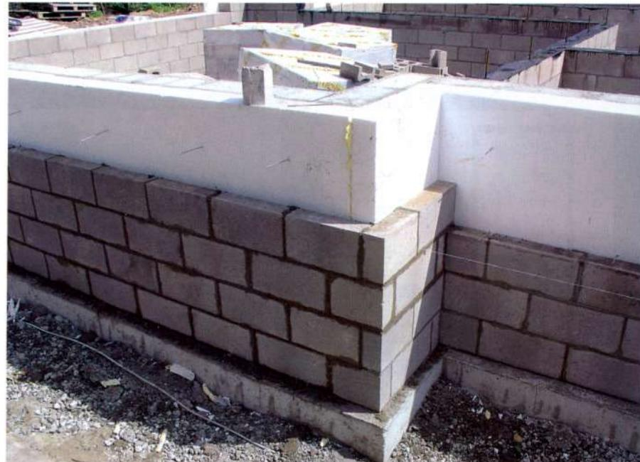
No dobajiem betona blokiem veidotajiem pamatiem ir ļoti plašas izmantošanas iespējas. Uz tiem var veidot sienas ne tikai no dobajiem betona blokiem, bet praktiski no jebkura biezuma sienu materiāla, kā arī vienslāņa un daudzslāņainas sienu konstrukcijas.
