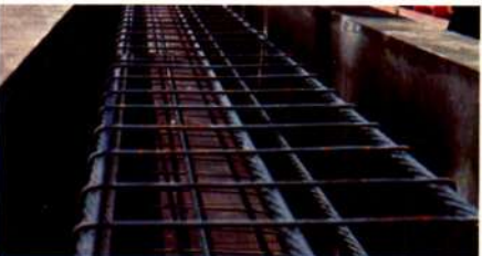
Stieņu armatūra pirms betona iestrādāšanas.
