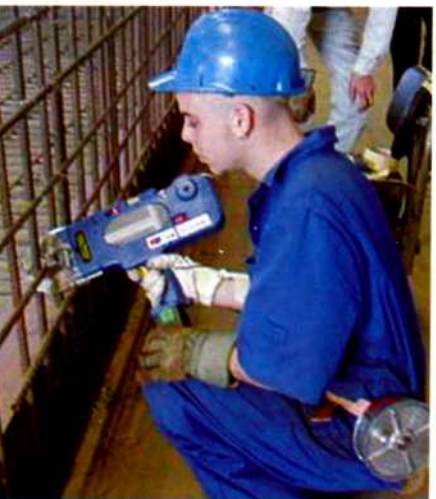
Armatūras siešanas pistole.
