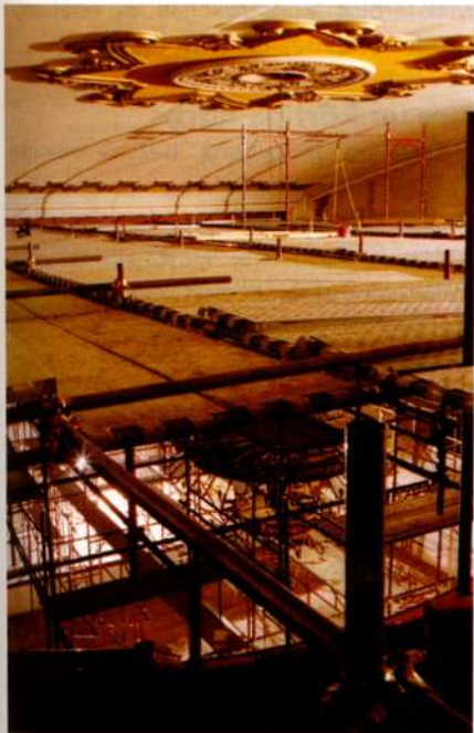
VEF kultūras pils zāles rekonstrukcijā izmantotas itāju firmas «Ponteggi Dalmine» sastatnes ar cauruļveida uzdevām, kas jāva būvēt sarežģītas konstrukcijas iekšējo sienu, griestu plafona un lustras paralēlai restaurācijai.
