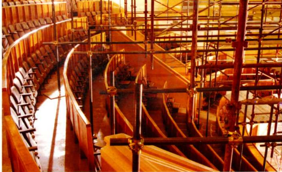
VEF kultūras pils zāles rekonstrukcijā sastatņu balstus izvietoja dažādos līmeņos, nedemontējot pat skatītāju krēslu rindas.
