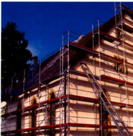
VEF kultūras pils zāles rekonstrukcijā izmantotas itāju firmas «Ponteggi Dalmine» sastatnes ar cauruļveida uzdevām, kas jāva būvēt sarežģītas konstrukcijas iekšējo sienu, griestu plafona un lustras paralēlai restaurācijai.
