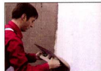
Ar rīvdēli uzklāj līmjavu 3 - 4 mm biezā kārtā.
