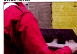
«Plastherm» klāj tieši uz putuplasta vai minerālvates.
