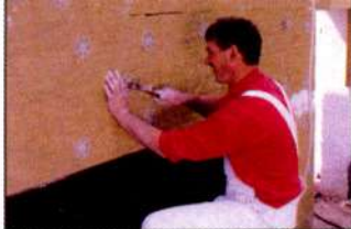
Līmjavas iestrādāšana ar dībeliem vai līmjavu nostiprina siltumizolācijas materiālu.
