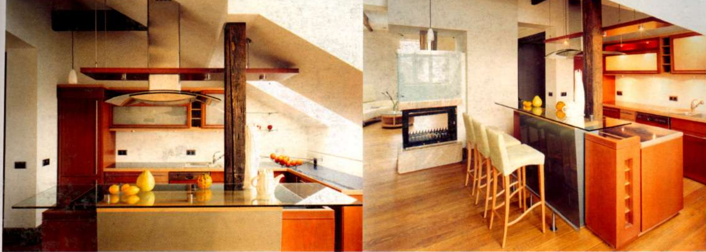
Lai iegūtu vertikālo telpu, tika veikta griestu pacelšana, atsedzot vēsturiskā pārseguma sijas.
