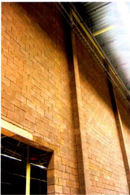
1. att. Pilastru izbūvei izmantoti «Columbia-Kivi» dobie betona bloki. Loģistikas centra zāles siena 14 m augstumā
