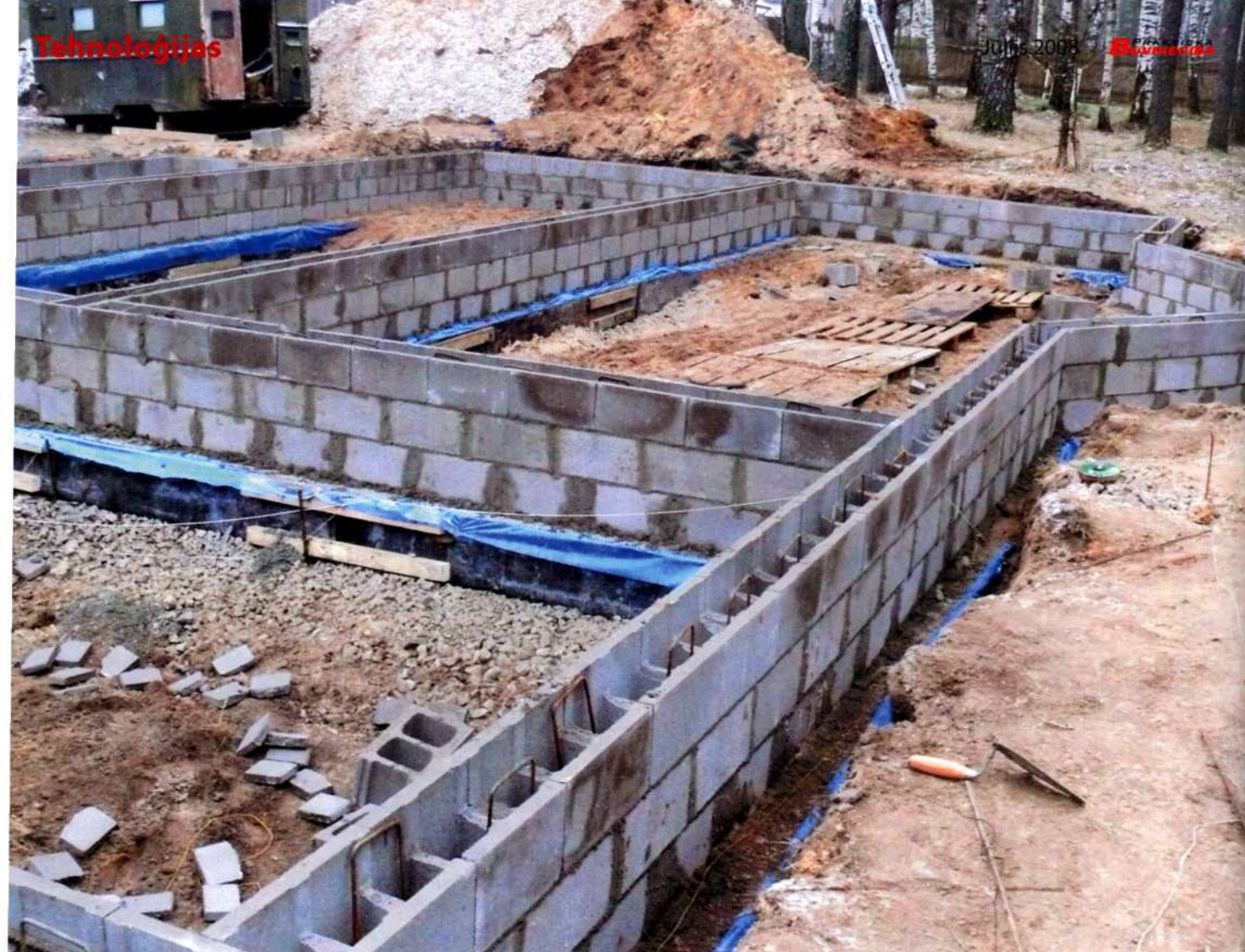
Dzelzsbetona joslas veidošana no armoblokiem Columbia-Kivi dobo betona bloku pamatu augšējā kārtā.
