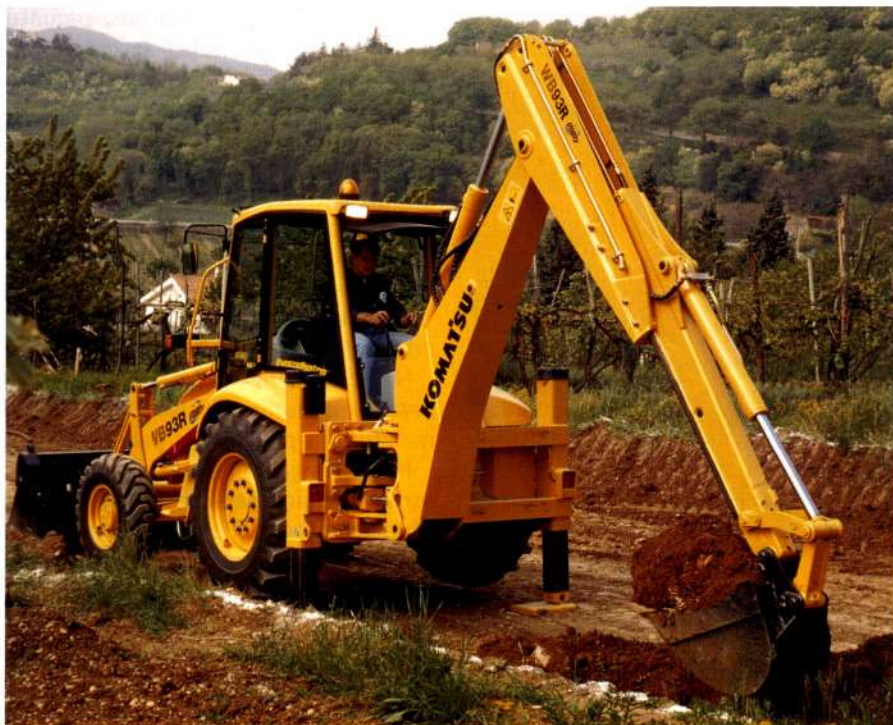
Būvbedres dziļums ir atkarīgs no vairākiem faktoriem. Rokot būvbedres 4,5 un vairāk metru dziļumā, jāveido būvbedres atbalsta sienas.
