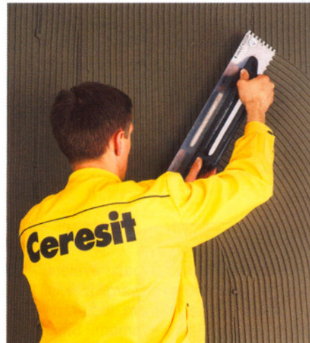
1. att. Līmjavas ieklāšana uz sienas ar zobšpakteli
