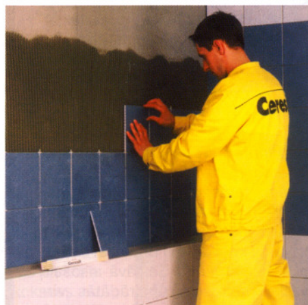
2. att. Plastmasas krustiņu ievietošana starp flīzēm un līmjavā iespīstās flīzes nolīdzināšana pēc tiem
