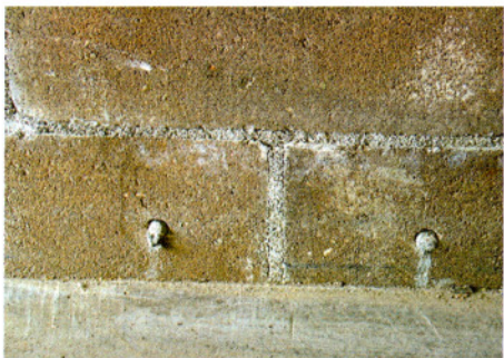
3. att. Pa caurumiem, kas izurbti Columbia-Kivi bloku apakšējā kārtā, izspiestā betonmasa liecina par dobumu aizpildījumu
