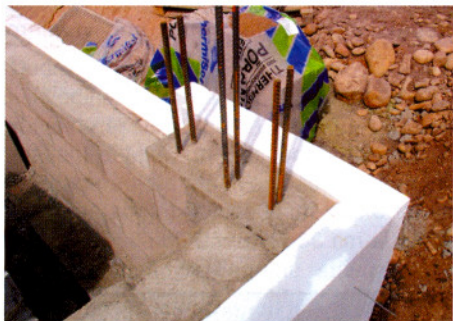
2. att. Aizbetonētie dobumi (apslēptās kolonnas)
