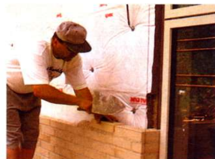
2. att. Pašventilējošas ārējo konstrukcijas veidošana privātmājai, izmantojot PAROC akmeņvates plāksnes un ķieģeļu apdari
