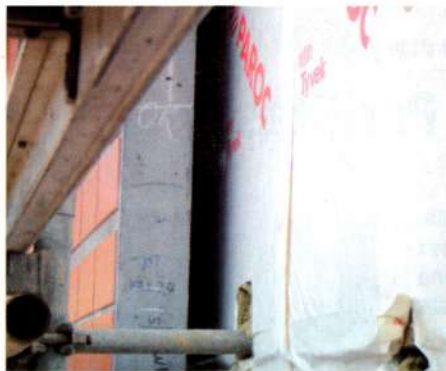
5. att. «Stockmann» tirdzniecības centra pašventilējošās fasādes gaisa šķirējslāņa veidošana
