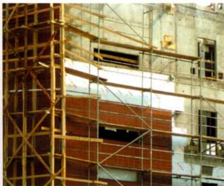
4. att. «Stockmann» tirdzniecības centra pašventilējošās fasādes risinājums
