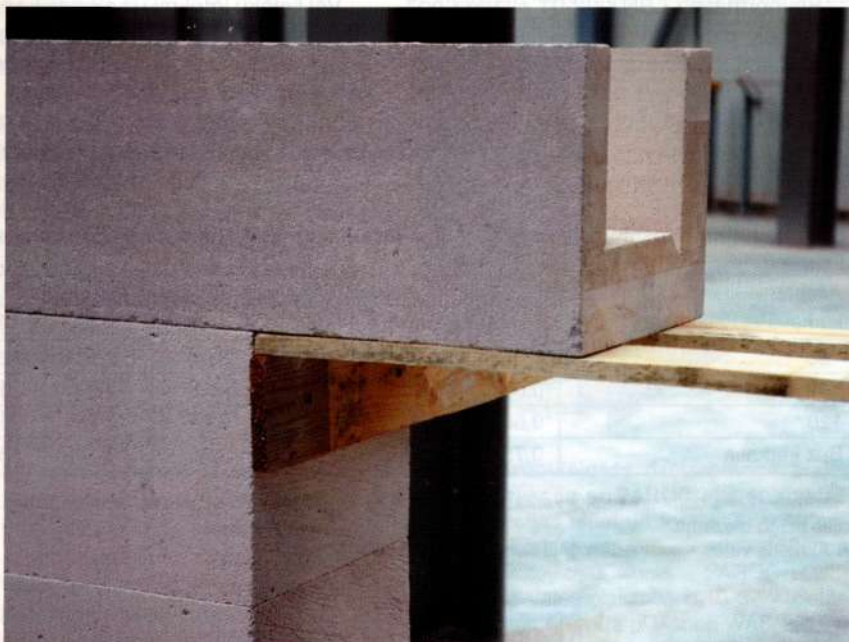
2. att. Ailu pārsedes veidošana no AEROC PoriClass U blokiem
