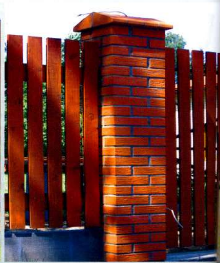
3. att. Žogs ar ķieģeļu stabiem un betona cokolu
