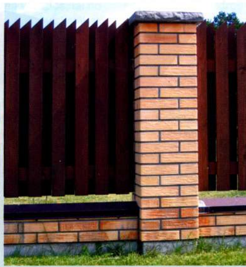
2. att. Žogs ar ķieģeļu stabiem un dubultdēļu aizpildījumu
