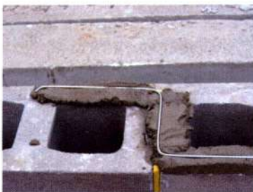
4. att. Z veida stiegras ievietošana deformācijas šuvē, guldot stiegru javas slāni
