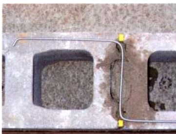
3. att. Pareizs Z veida stiegras novietojums pa vertikālās šuves vidū virs ruberoida starplikas, kas atdala blokus
