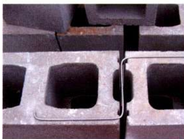
2. att. Z veida stiegra ar nolocītiem galiem
