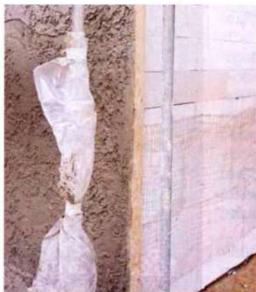
1. att. Cokola apdare. Siena nav gruntēta, sieta iestrādāšanas tehnoloģija nepareiza, jo sietu vajag iespiest svaigi uzvilkta armējošās javas kārtā
