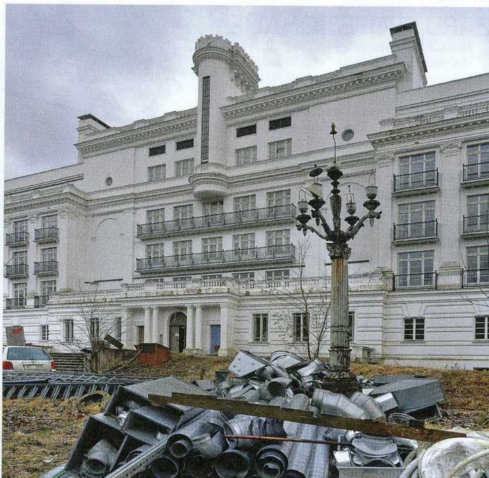
Kaut apkārt mīkaste, ēkas cēlo skaistumu tā nevar nomākt. Objektu apmekle Valsts kultūras pieminekļu aizsardzības inspekcijas amatpersonas – Jūnis Dambis, Vivita Mačiņa, Jānis Asaris, Dace Mikelsona. 09.01.2014.
