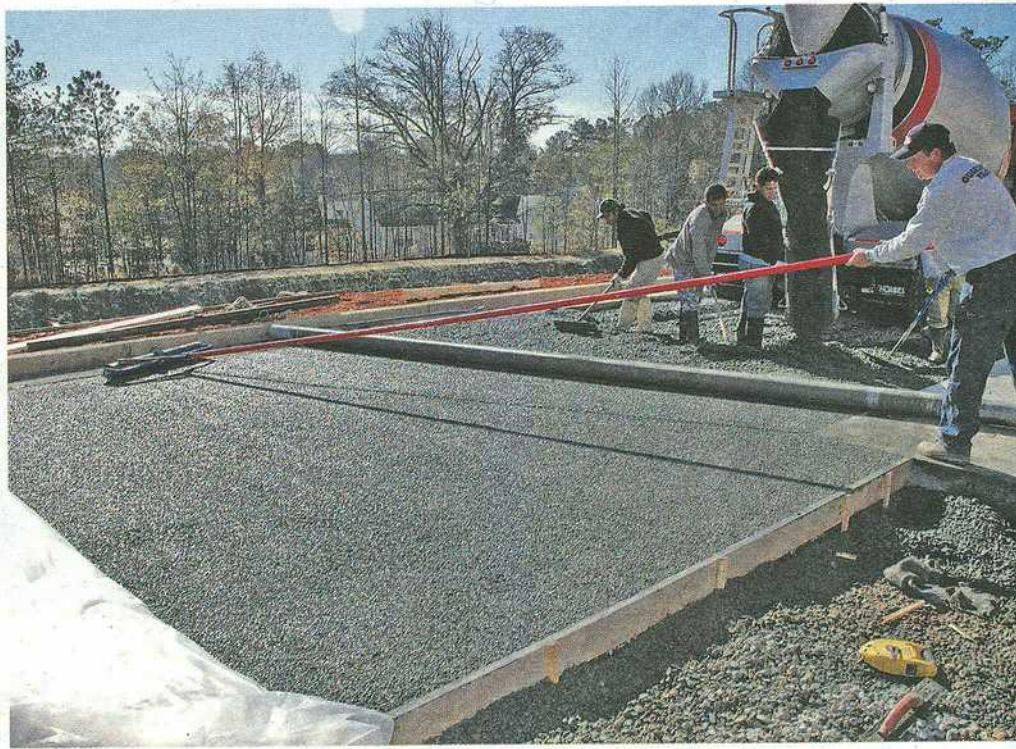
Parasti betonu veido pēc iespējas blīvāku, jo tad tam ir labākas mehāniskās īpašības un tas ilgāk kalpo, taču ar filtrējošo betonu (perVIOUS CONCRETE) ir citādi. Savā veidā šis materiāls imitē dabisku gruntu, jo starp salīmētajām betona daļiņām veidojas daudzas poras – tās aizņem līdz 25% kopējā apjoma. Un tieši šī lielā porainība nodrošina ūdens filtrācijas spēju, turklāt iespaidīgā apjomā – līdz 200 litriem minūtē uz 1 m<sup>2</sup> seguma.
