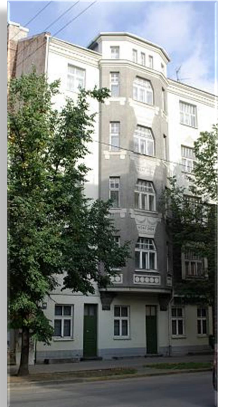
Nams Rīgā Stabu ielā 99. Fasādes fragments. 1909. gads - A. Malvess. Zvaigzne, Nr.2 (20.01.1990) (periodika.lv)
